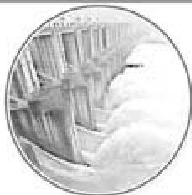
水电总装机容量
